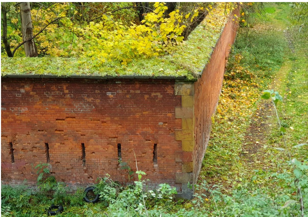
Zdjęcie 2. Mury Cytadeli Warszawskiej (fot. Tomasz Chodkiewicz).
