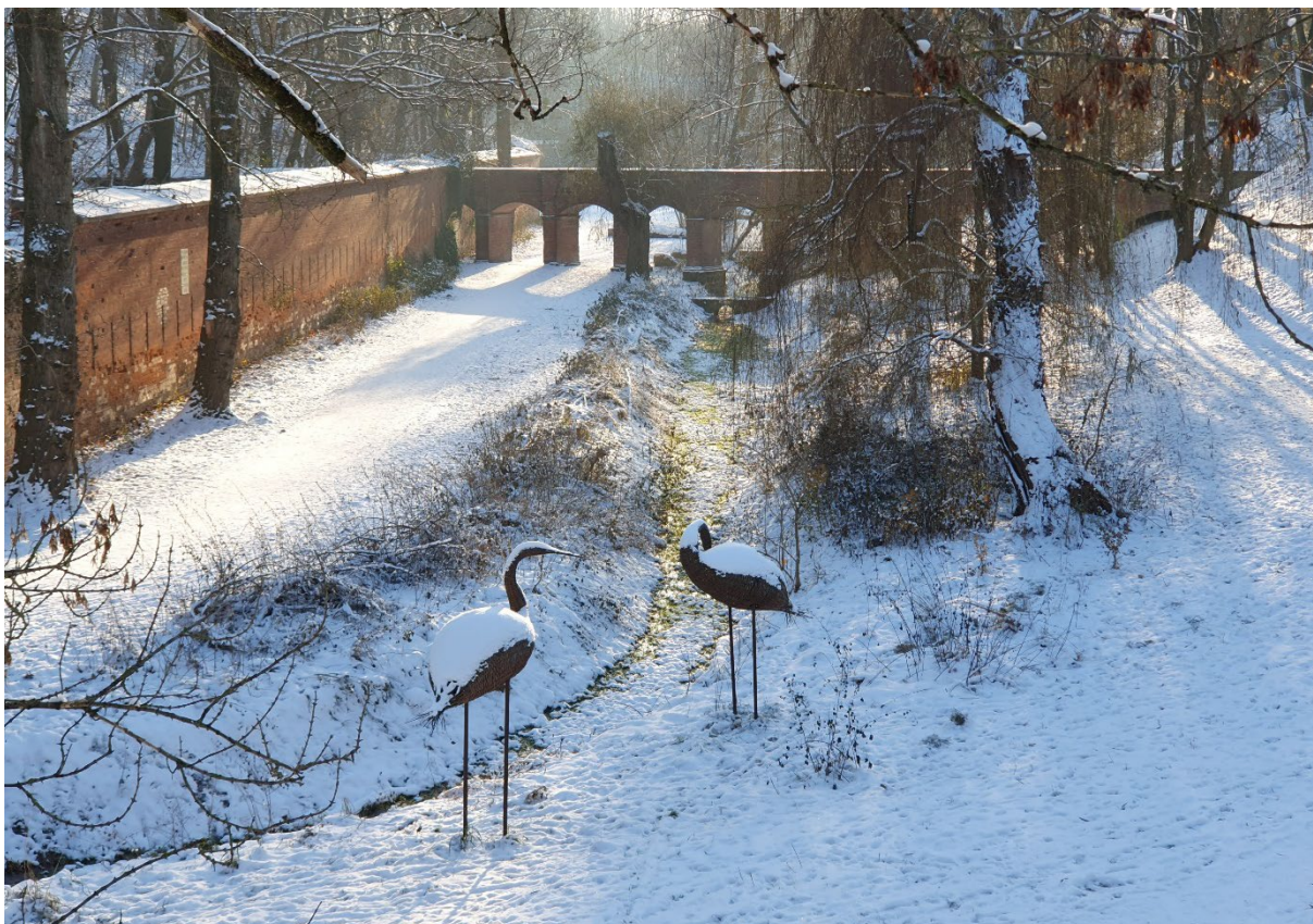
Zdjęcie 4. Fosa Cytadeli Warszawskiej – koryto rzeki Drny (fot. Tomasz Chodkiewicz).
