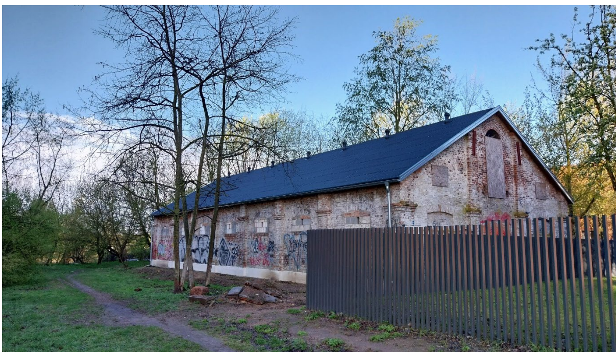
Zdjęcie 7. Zniszczone zabudowania we wschodniej części powierzchni badawczej (fot. Adam Dmoch).
