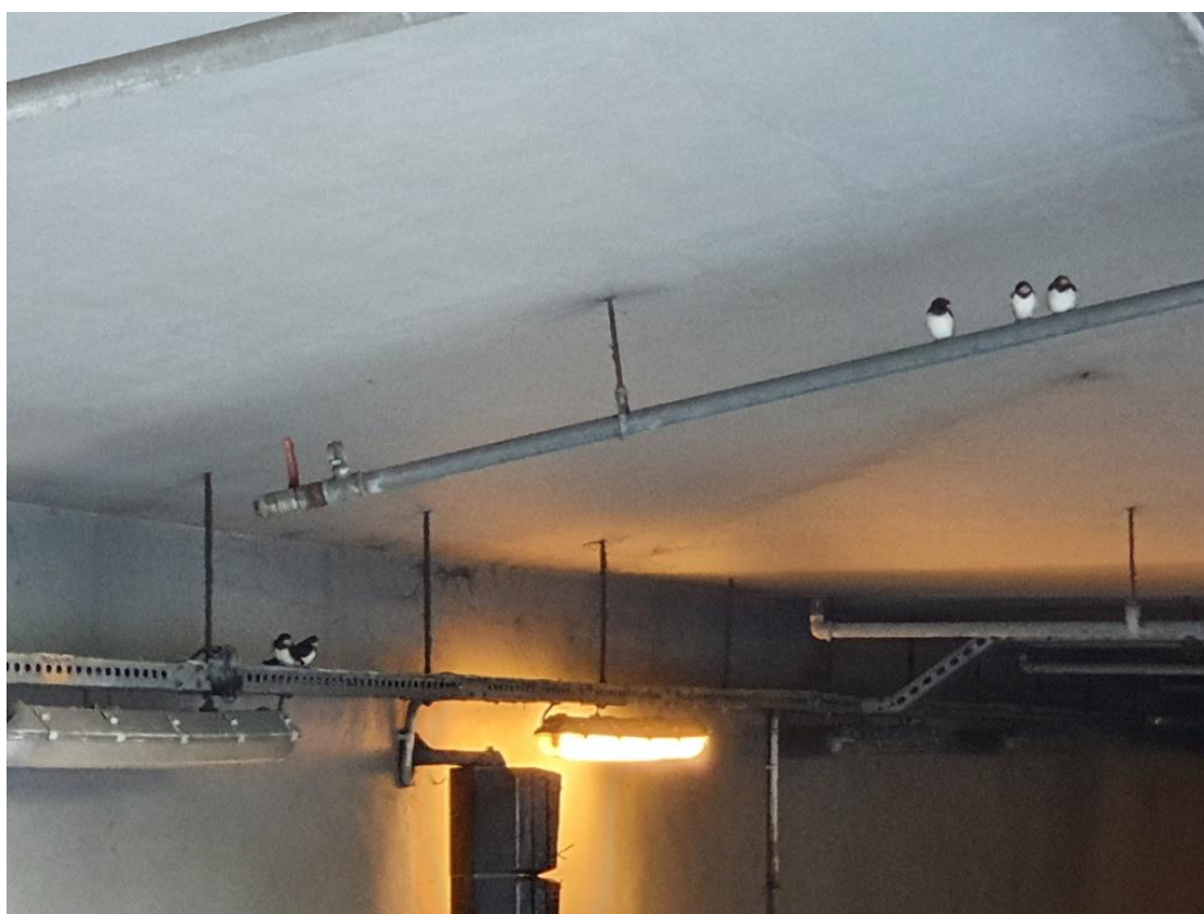
Zdj. 4. Podloty dymówek przy wjeździe do podziemnego garażu na Placu Krasińskiego, 27.06.2022 r. (fot. Tomasz Chodkiewicz)
