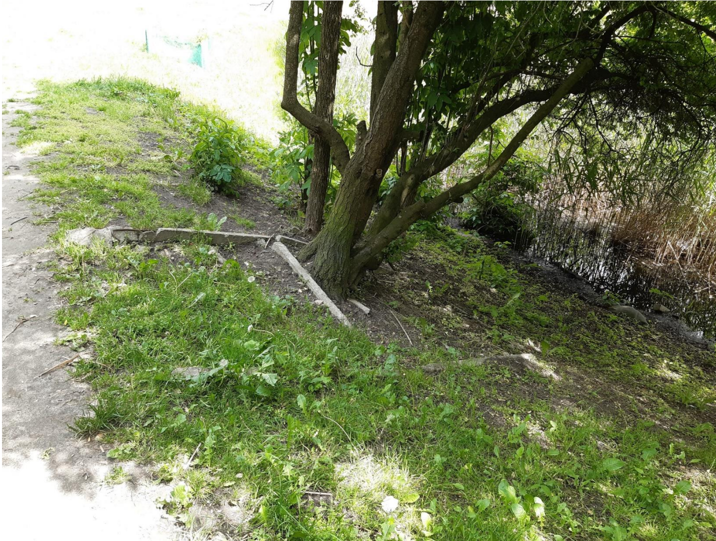
5. Jedne z dwóch pozostałości po schodach przewidziane do likwidacji. Na zdjęciu schodki w części północnej.
