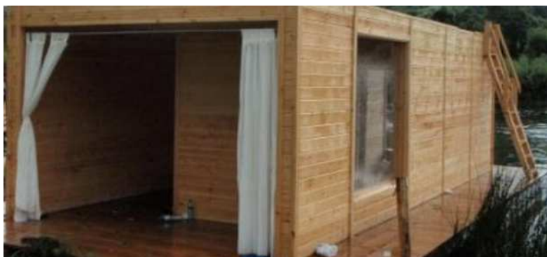
Fot. nr 5: Źródło: https://sztuka-architektury.pl/article/8646/442/plywajaca-sauna-page-5
