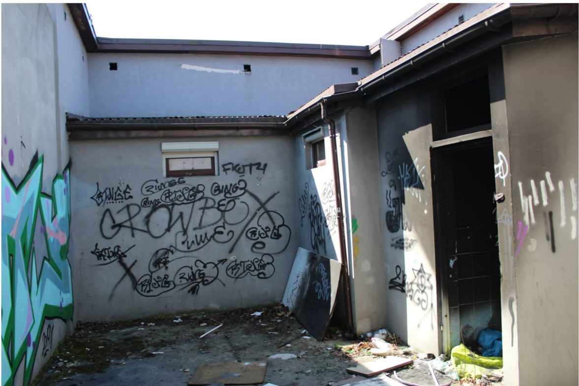
Fot. 1.6 Elewacja od strony dziedzińca
