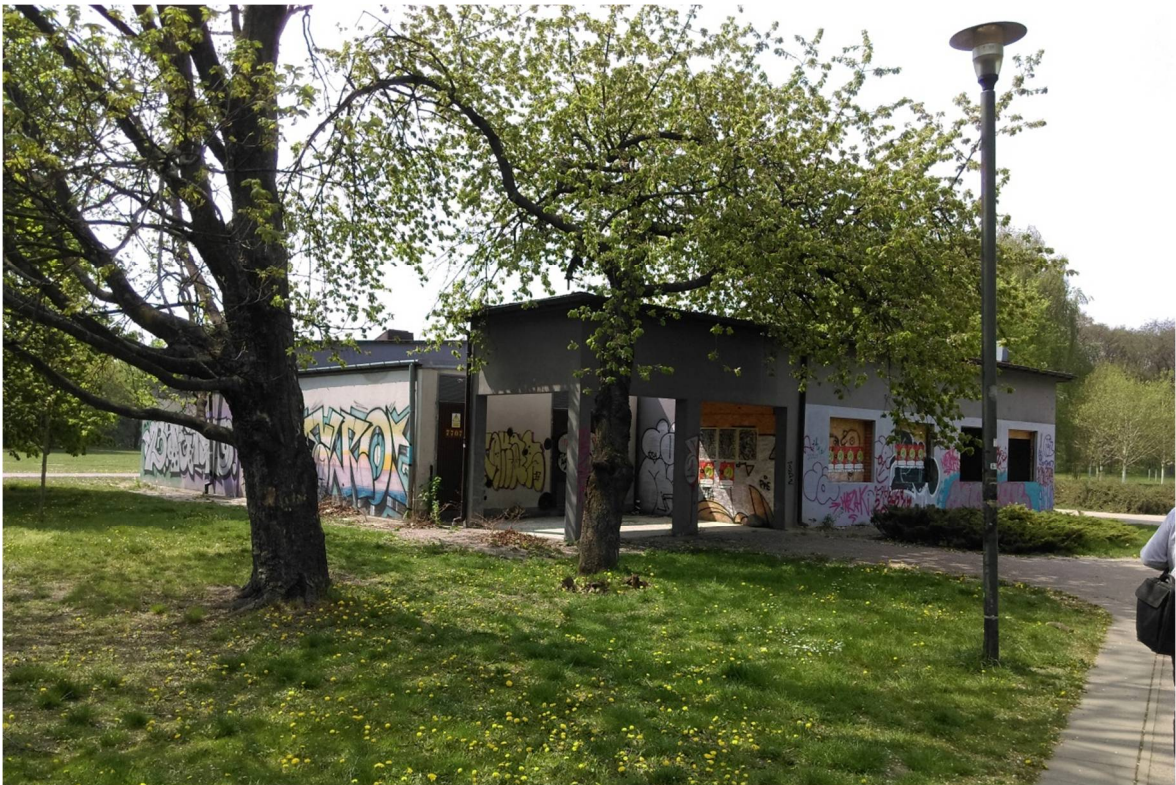
Fot. 1.5 Elewacja północno - zachodnia
