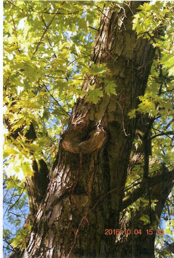
Otwór destrukcji wgłębnej drewna
