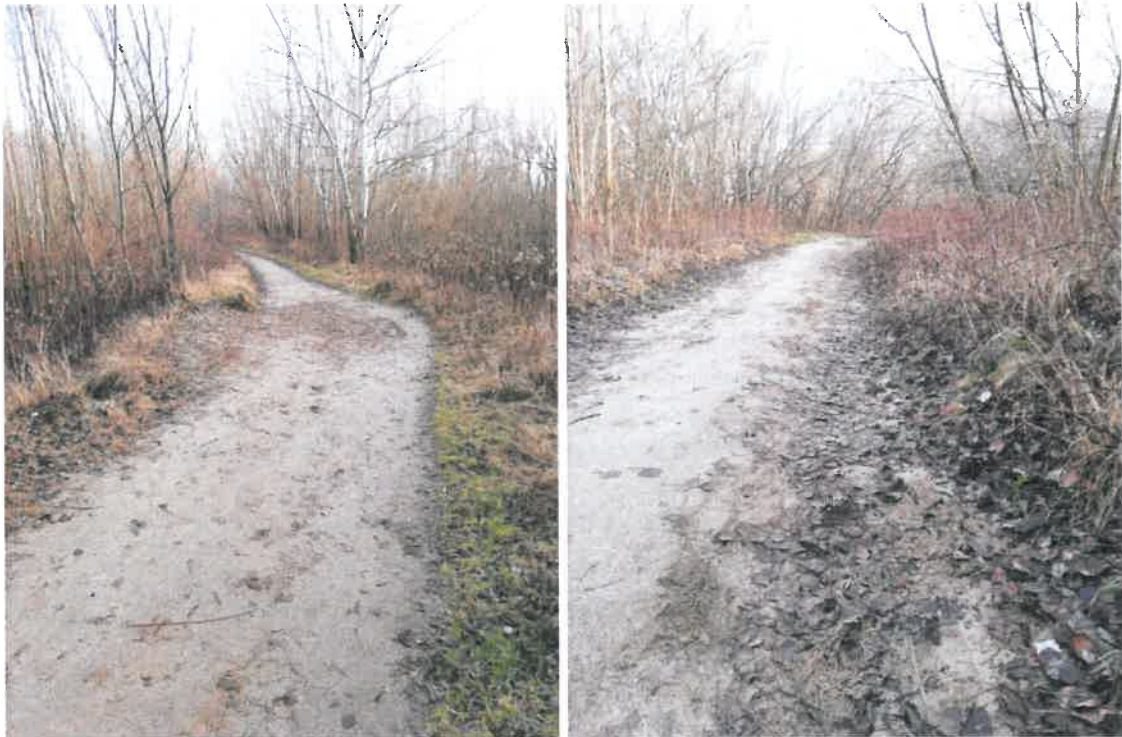
Fot. 3 - 4. Ścieżka gruntowa
